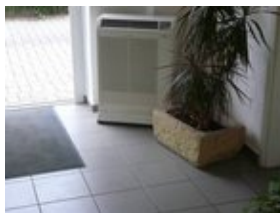
Splitklimaanlage als Standgerät Leistung 4,0 kW
