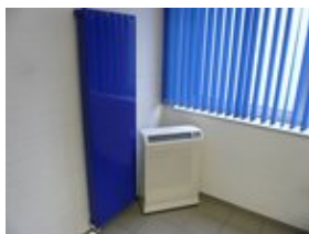
Splitklimaanlage als Standgerät Leistung 2,9 kW
