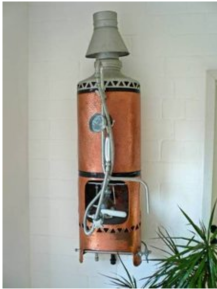
Funktionstüchtiger Durchlauferhitzer DB 35 / Z Baujahr 1910
